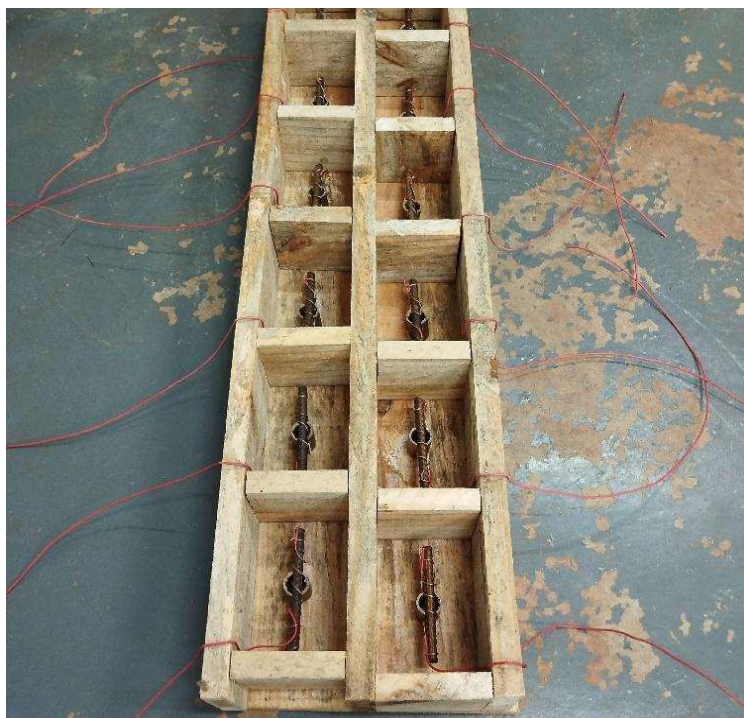
Figura 4. Armadura alocada na forma.
