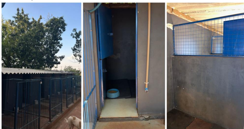
Figura 5 – Detalhe das baias evidenciando a estrutura e divisórias
