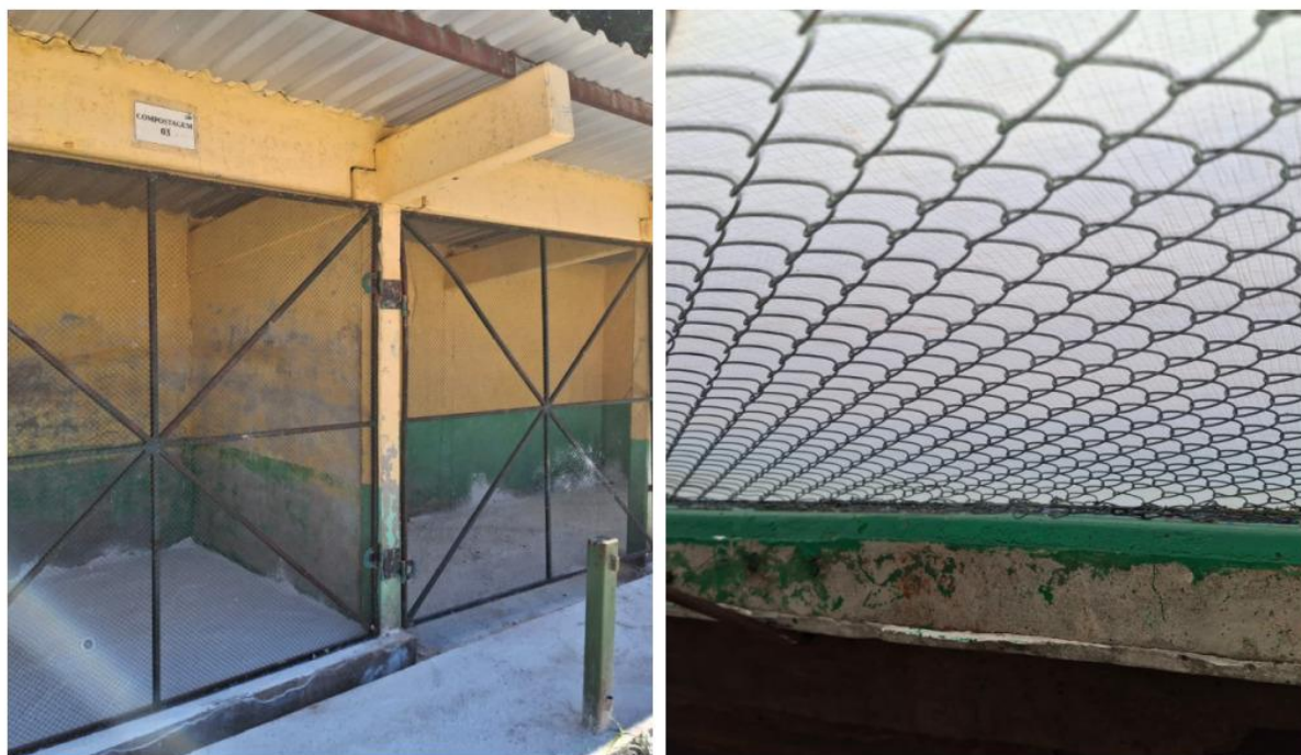
Figura 9 – Instalações adequadas em granjas com ninhos automáticos
