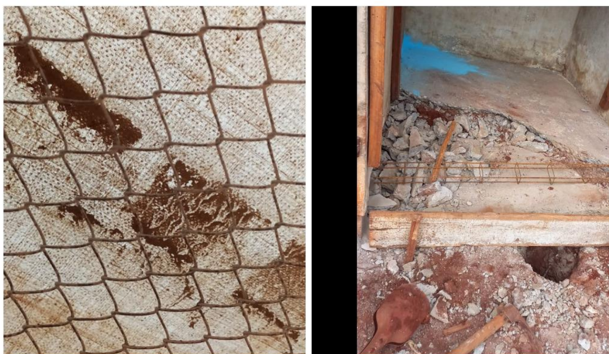
Figura 10 – Não conformidades em granjas com ninhos manuais
