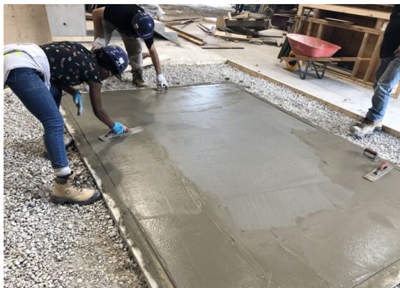
Figura 4 - Execução de contrapiso
