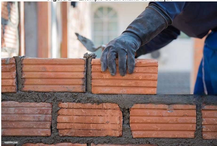
Figura 2 – Exemplo de alvenaria de vedação
