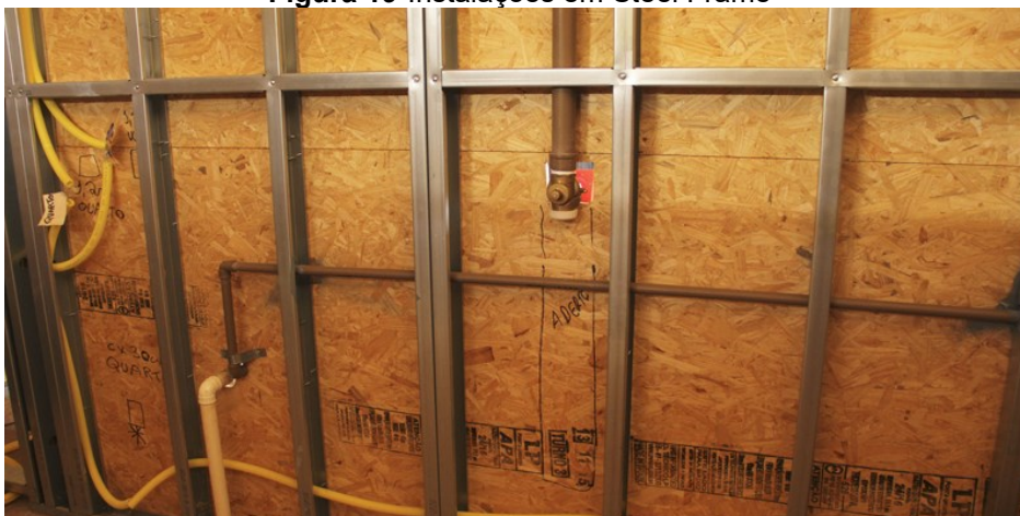
Figura 19 -Instalações em Steel Frame
