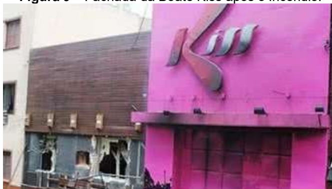
Figura 9 – Fachada da Boate Kiss após o Incêndio.
