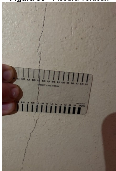
Figura 33 - Fissura vertical.
