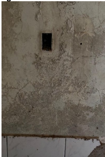
Figura 40 - Pintura escamada.
