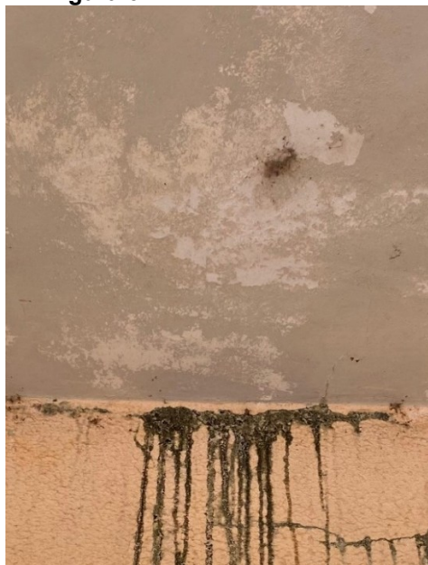
Figura 62 - Eflorescência salina.
