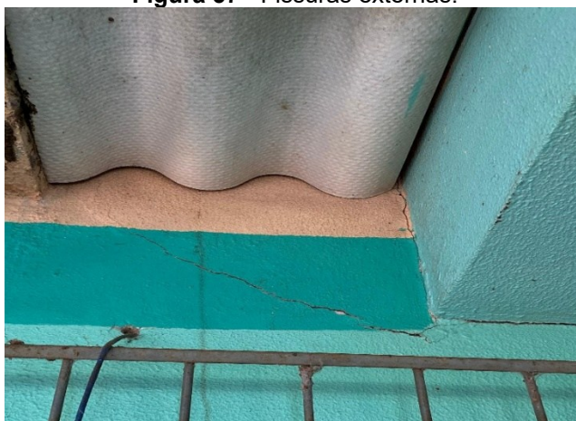
Figura 57 - Fissuras externas.
