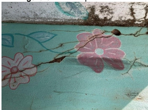
Figura 64 - Recalque diferencial.
