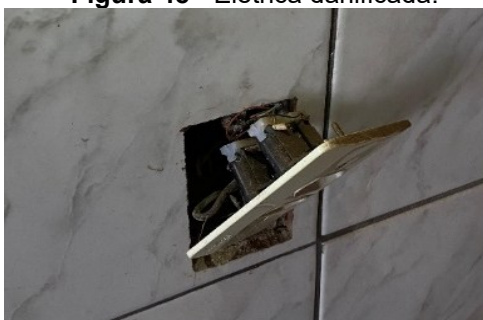
Figura 48 - Elétrica danificada.
