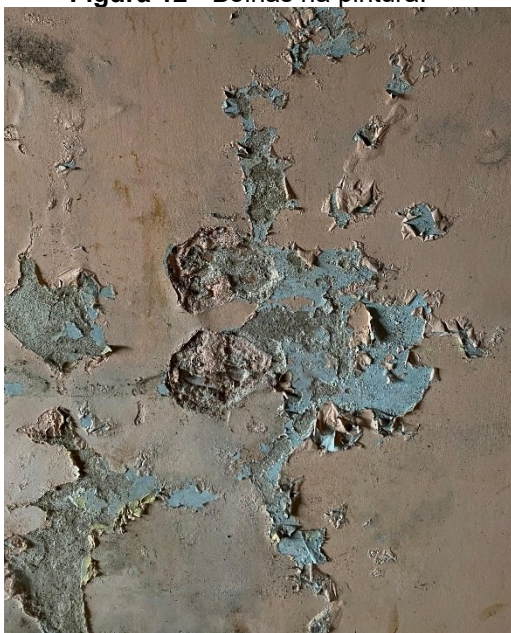
Figura 12 - Bolhas na pintura.
