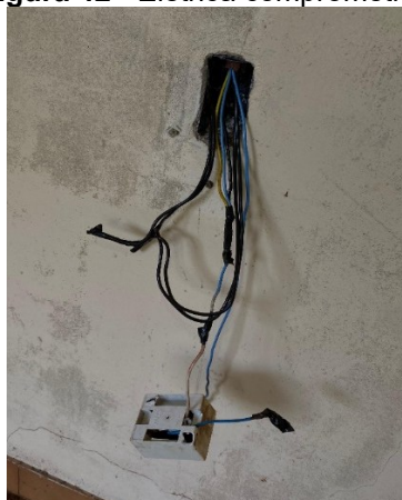
Figura 42 - Elétrica comprometida.
