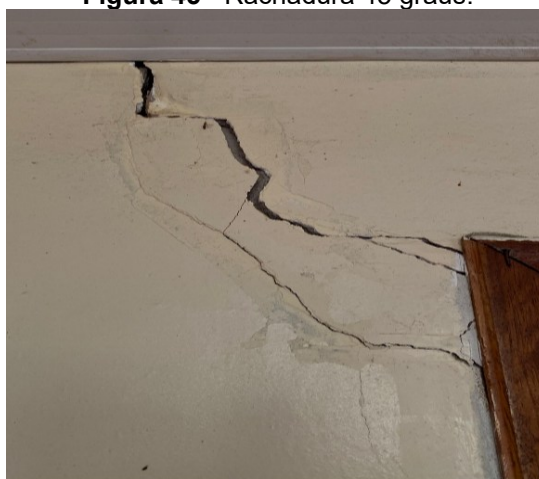
Figura 45 - Rachadura 45 graus.
