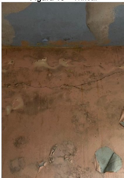
Figura 15 – Trinca.
