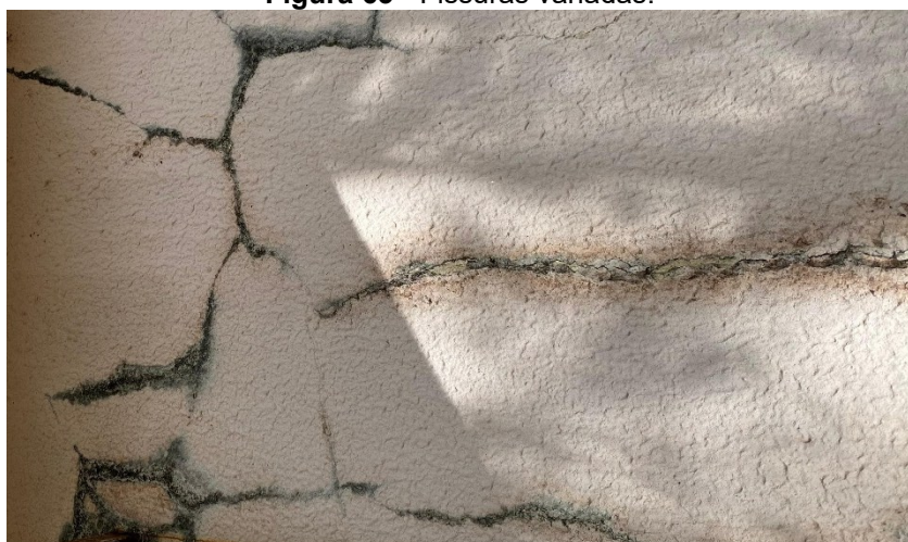
Figura 63 - Fissuras variadas.
