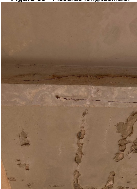
Figura 60 - Fissuras longitudinais.
