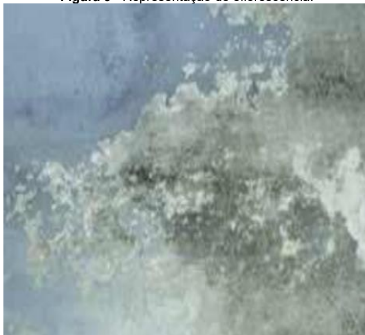
Figura 3 - Representação de eflorescência.
